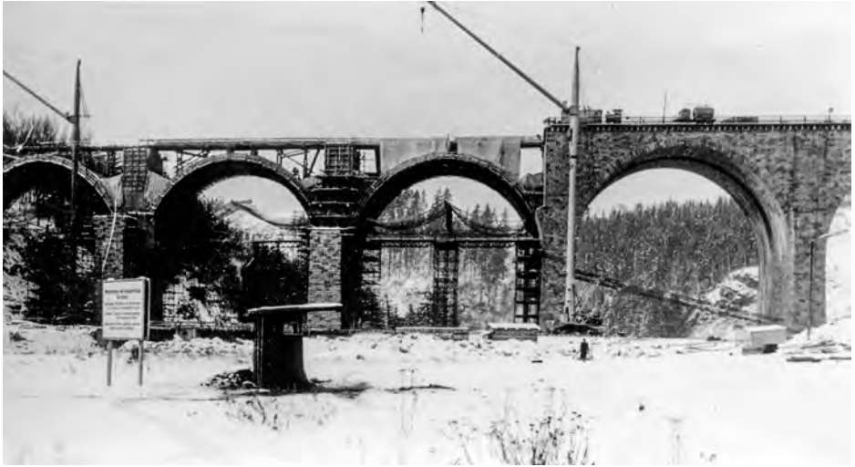
Abb. 4: Wiederaufbau der gesprengten Bögen der Autobahnbrücke über die Saale bei Hirschberg, 1965/66
