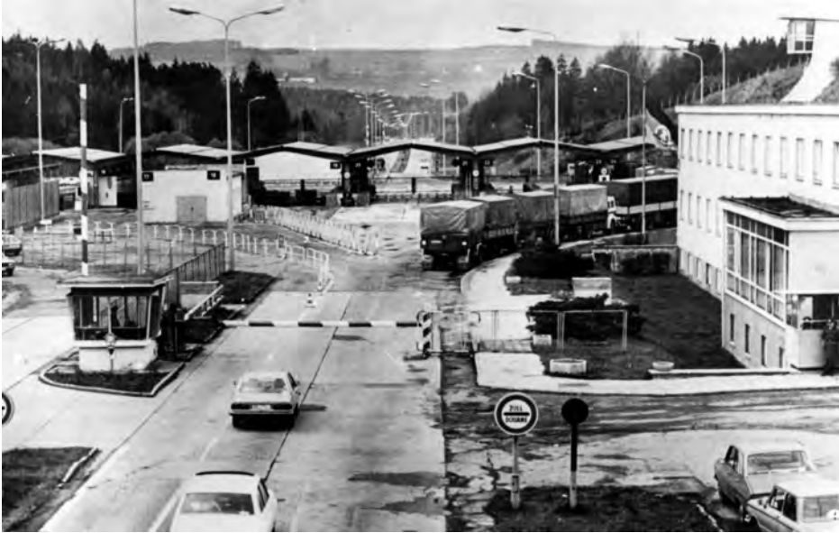
Abb. 3: Einfahrt in die Autobahn-GÜSt Hirschberg (Blickrichtung nach Westen), nach 1966
