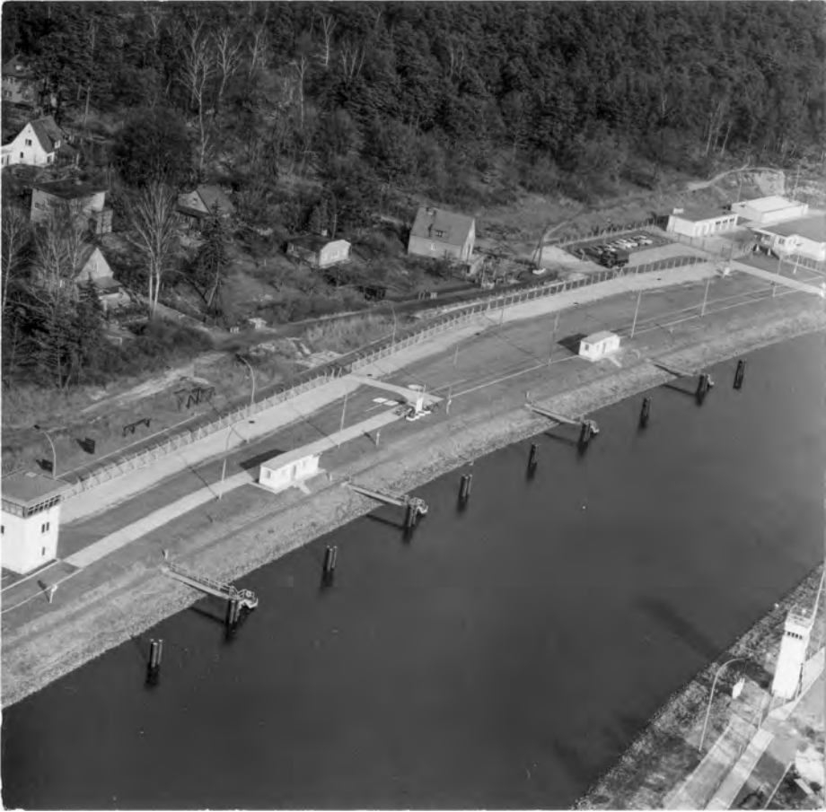
Abb. 9: Luftbild der Wasserstraßen-GÜSt Dreilinden am Teltowkanal, nach 1981
